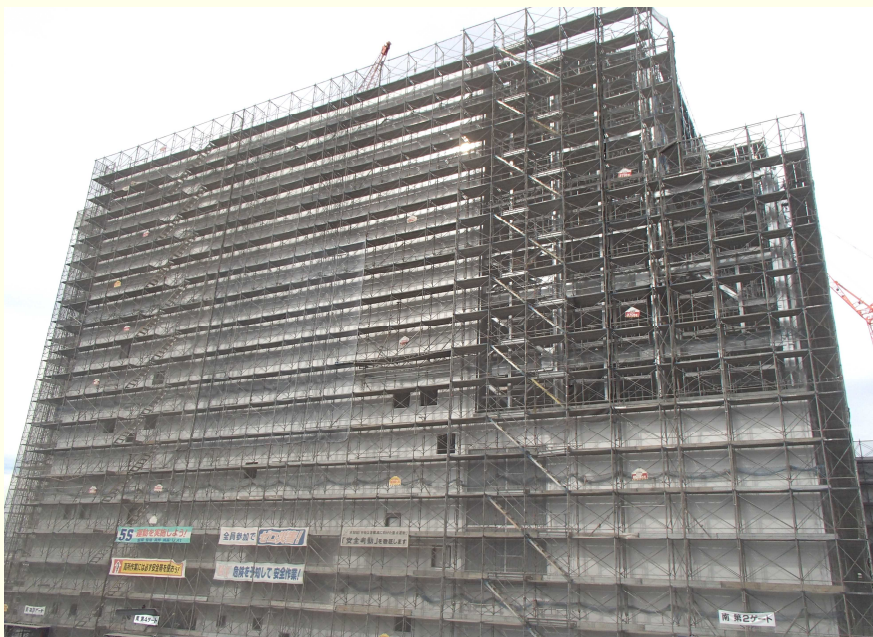
南面の外壁張りの状況【10月16日撮影】
