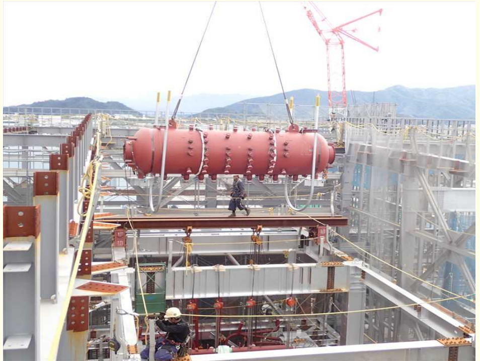
炉室最上部 ボイラドラムの搬入状況【9月29日撮影】
