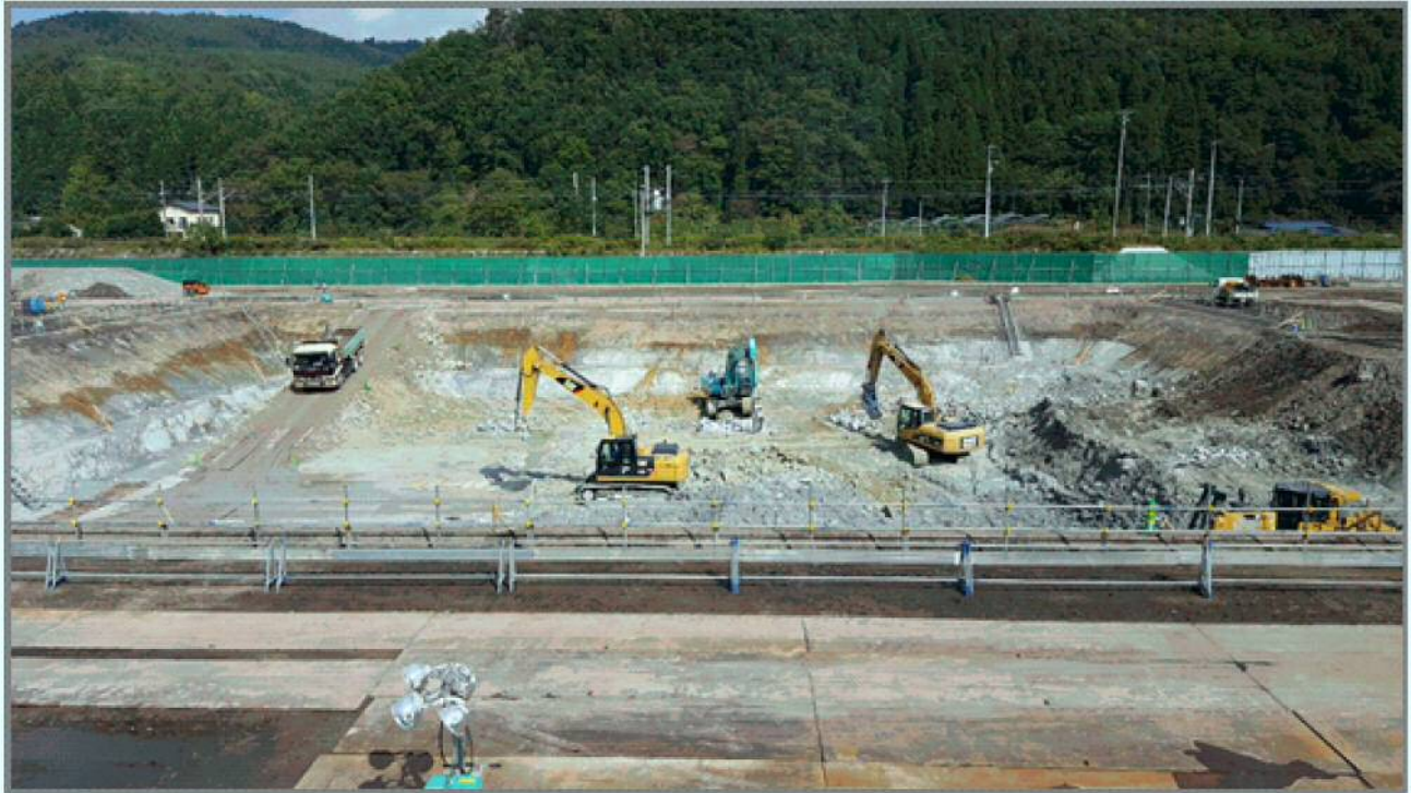
現在の建設現場のようす【平成28年10月7日撮影】
