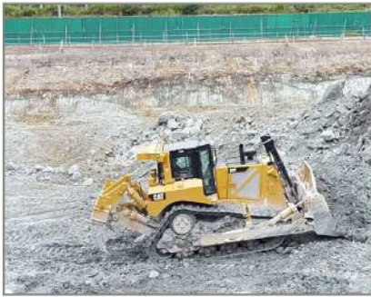
【 ブルトーザーでの破碎・集積 】
