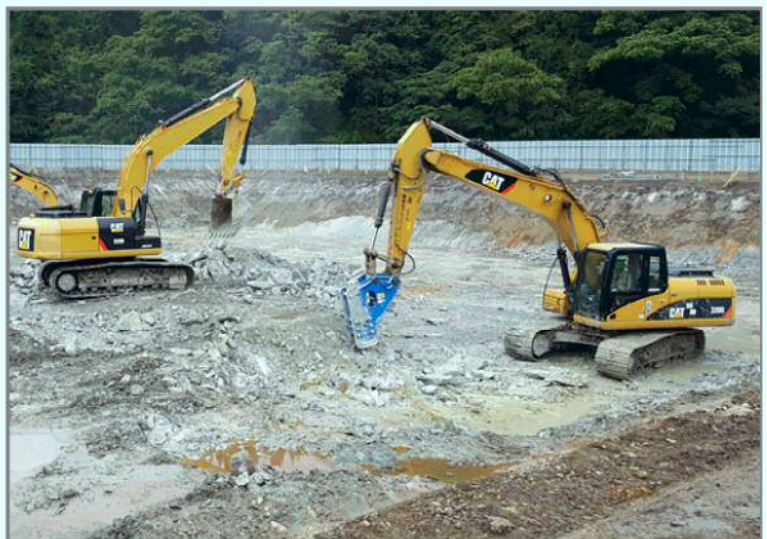
地盤掘削のようす【平成28年10月7日撮影】
