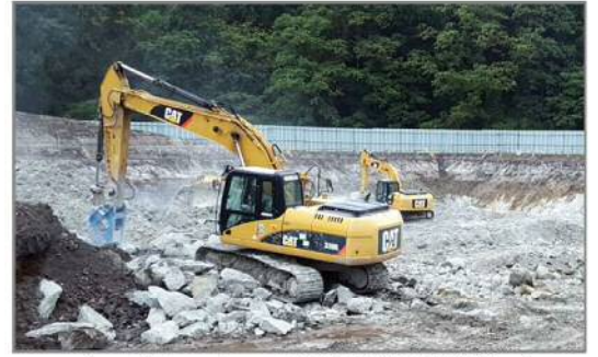
【 ブレーカーでの岩盤面の破碎 】
