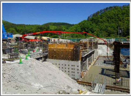
●コンクリート打設のようす【地下2階】 ポンプ車でコンクリートを流し込んで床をつくっています。
