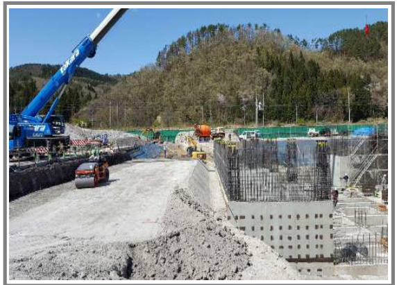
●建物周囲の埋め戻しのようす 締め固めながら埋め戻すことで地盤に強度を持たせます。
