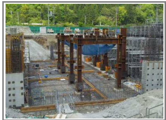
●鉄骨組立のようす【地下2階】 鉄骨鉄筋コンクリートの柱や梁を組み立てています。
