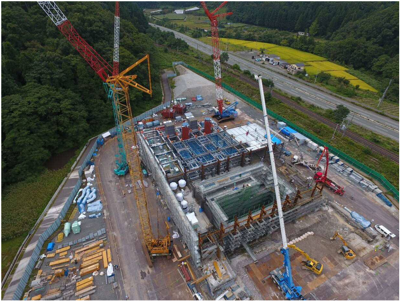
建設現場上空からのようす【9月20日撮影】
