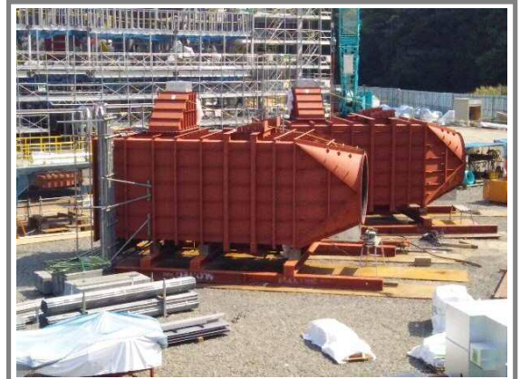
● ろ過式集じん器（バグフィルタ）【9月20日撮影】 排ガス中の飛灰等を除去する装置です。大型の機器は分割して搬入し、現場で組み立てます。
