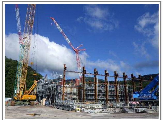
処理棟東側のようす【8月31日撮影】
