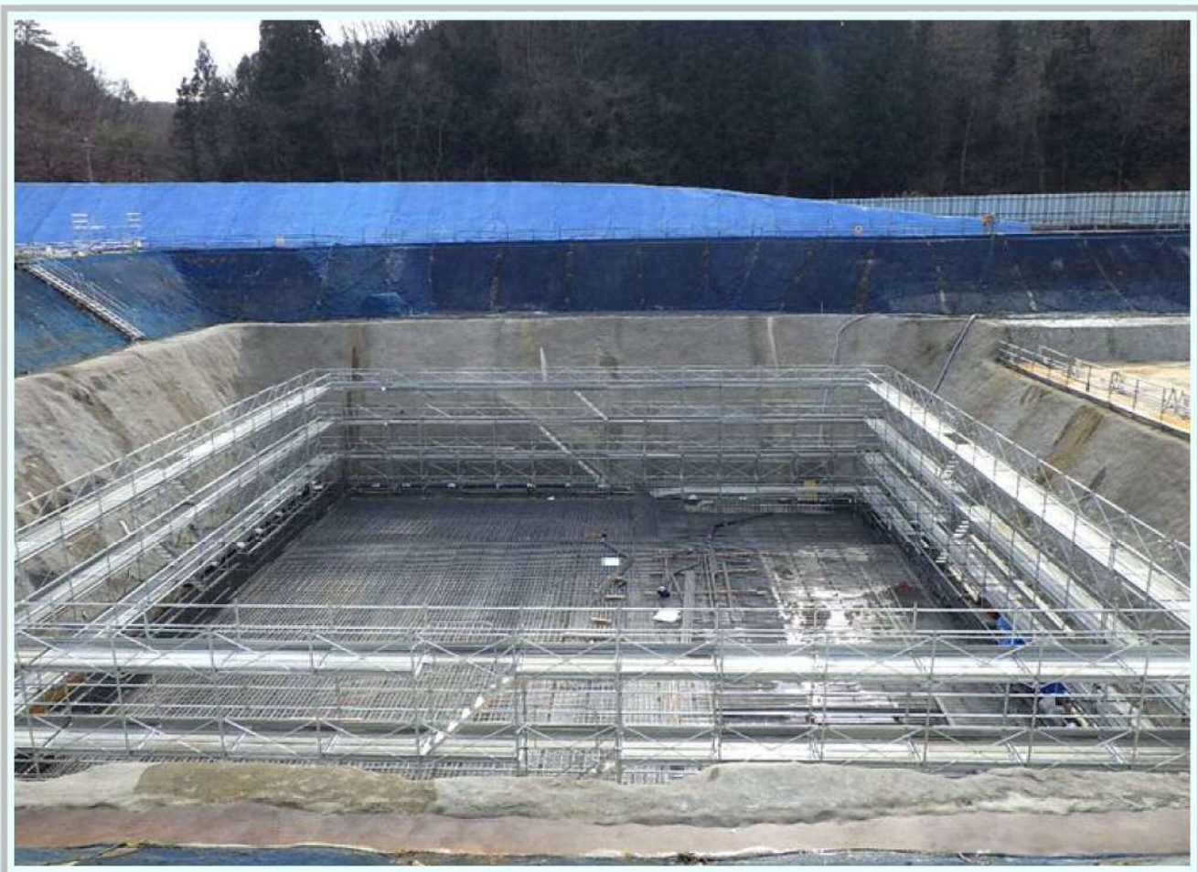
現在の建設現場のようす【平成28年12月26日撮影】
