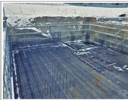
鉄筋工事のようす 【平成28年12月28日撮影】 基礎部分（耐圧盤）の鉄筋組み立て を行っています。
