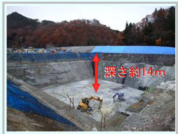
地盤の掘削（根切り）完了のようす【平成28年11月28日撮影】
