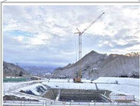
【100tクローラークレーン】 大型のクレーンで資材を下ろします。
