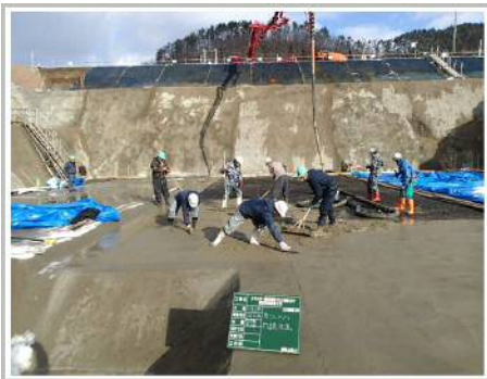
捨てコンクリート打設のようす 【平成28年12月12日撮影】 墨出し、鉄筋・型枠工事に向けて 捨てコンクリートを打設しました。
